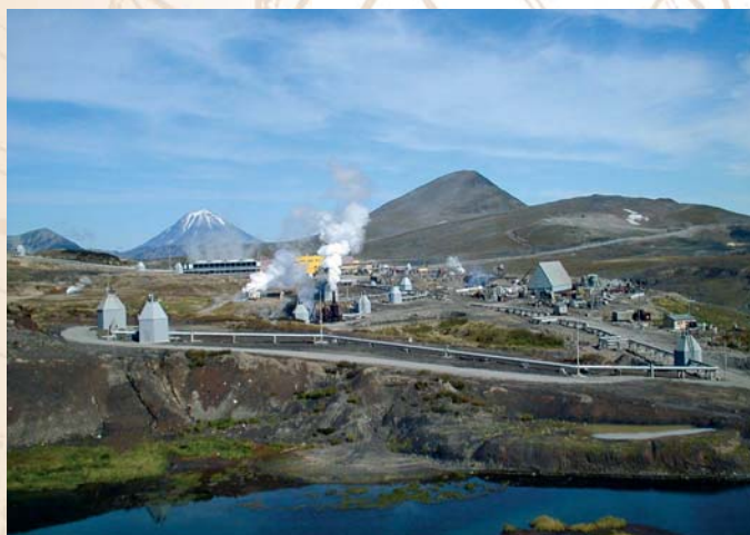
Мутновская ГеоЭС строится
