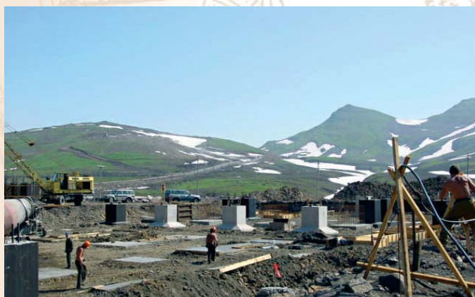
Строительная площадка Мутновской ГеоЭС
