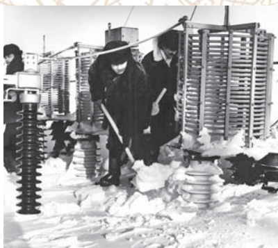
Расчистка подстанции после пурги. 1980-е гг.
