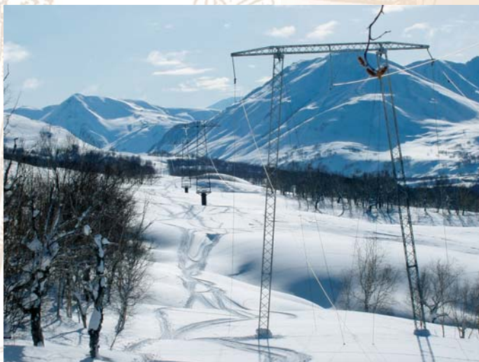
Линия МгеоЭС – подстанция «Авача»
