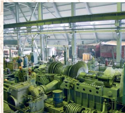
Установка турбин на МгеоЭС
