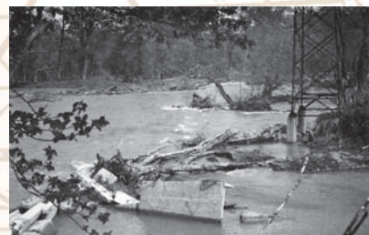
Создание искусственных намывов вокруг опор
