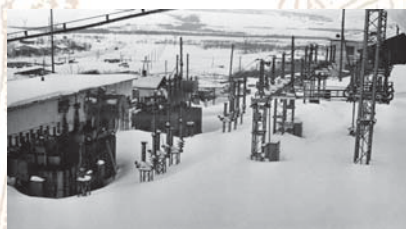
Подстанция «Зеркальная». Зима 1968 г.
