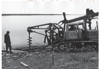
Строительство перехода в Усть-Камчатске
