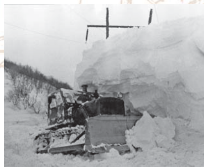
Расчистка снега пролета ВЛ– 110 кВ. 1970-е гг.
