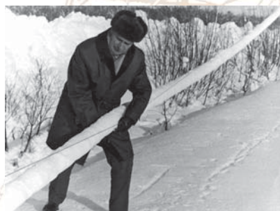
Гололедные явления на линиях электропередачи. Зима 1971 г.
