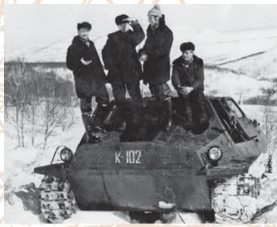
Проезд трассы ВЛ-110, ул. Тундровая. Февраль 1972 г.
