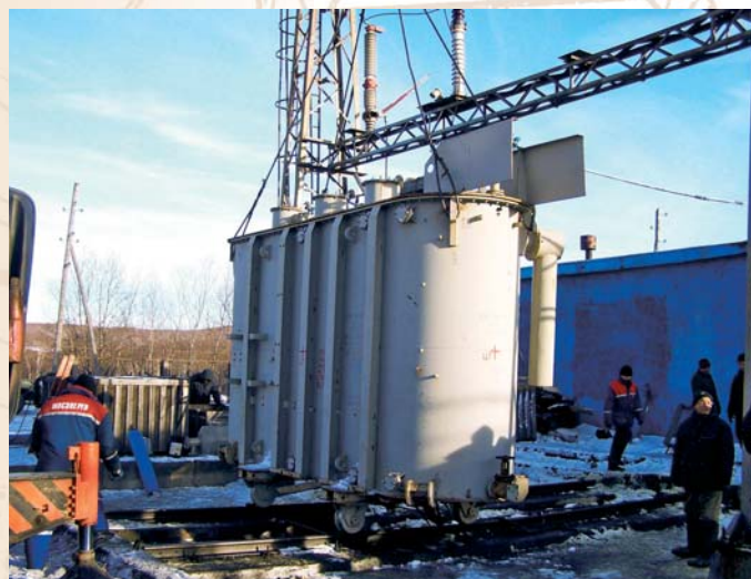
Установка нового трансформатора на ПС «Дачная», 2007 г.
