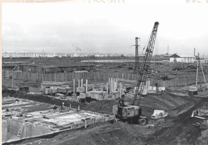
Строительство ДЭС-23. Усть-Камчатск. 1970-е гг.
