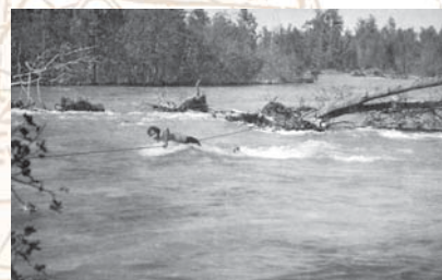
Работа по спасению от подмыва опор ВЛ. 1970-е годы
